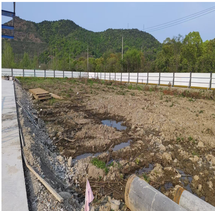
柯桥区杨汛桥芝塘湖储能及配套用房项目现状图
