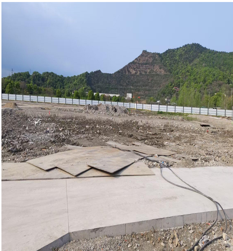
柯桥区杨汛桥芝塘湖储能中心用房项目现状图
